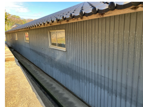
(左) 富来漁港の倉庫内と (右) 赤住漁港 (南) の倉庫外壁に残された津波痕跡。2024年1月5日撮影。
