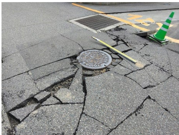
写真 8 - 7 : 道路の亀裂
