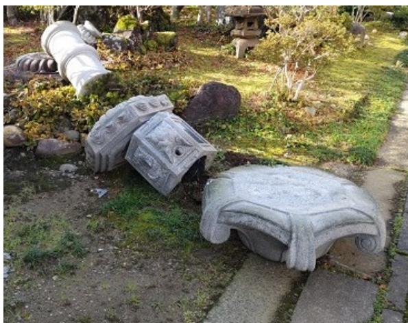
写真 8 - 11 : 石灯籠の転倒及び倒壊
