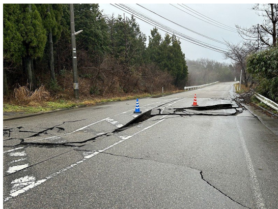
写真8-1：道路の亀裂
