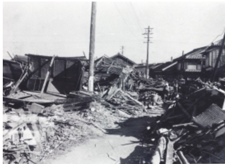
昭和19年(1944)年12月7日 東南海地震による半田市内の被災状況
