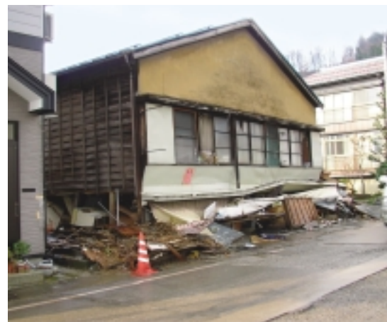
H16(2004).10.23 新潟県中越地震の建物被害(川口町)
