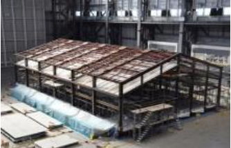
H25(自体研究)：文科省と国交省との情報交換に基づく、体育館の吊り天井落下評価実験
