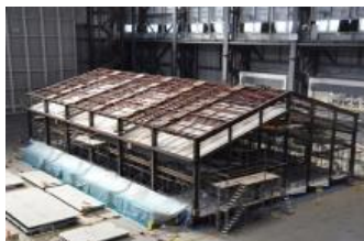
H25(自体研究)：文科省と国交省との情報交換に基づく、体育館の吊り天井落下評価実験
