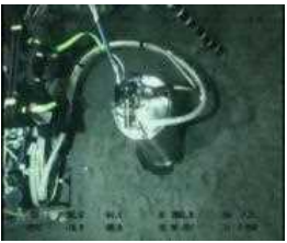
海底に設置作業中の地震計
