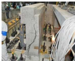
衝突後の擁壁の状況
