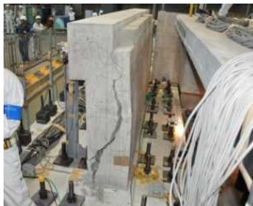
衝突後の擁壁の状況
