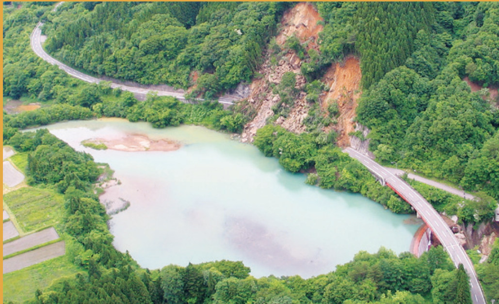
平成20年(2008年)岩手・宮城内陸地震により発生した土砂災害 (岩手県南広域振興局一関総合支局提供)
