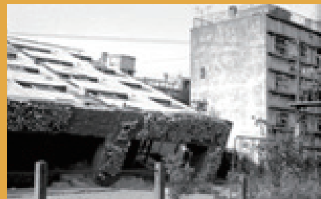
液状化による建物の転倒(新潟地震) (戸田建設株式会社提供)
