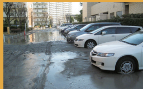
噴砂の状況(東北地方太平洋沖地震) (千葉県浦安市富岡エステート住宅管理組合自主防災隊提供)
