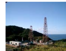
観測施設整備工事風景
