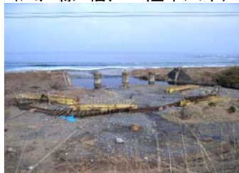
E【線路流失】 ほそうら (大船渡線 細浦構内)
