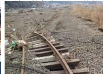
J【道床流失】 のびる (仙石線 野蒜構内)
