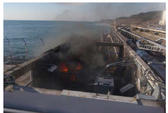
東京電力(株)福島第一原子力発電所 4号機の火災(東京電力HP(4月12日撮影)より)
