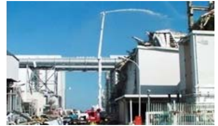
緊急消防援助隊による3号機への 放水(東京消防庁HPより)
