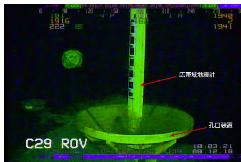
長期孔内計測装置降下作業
