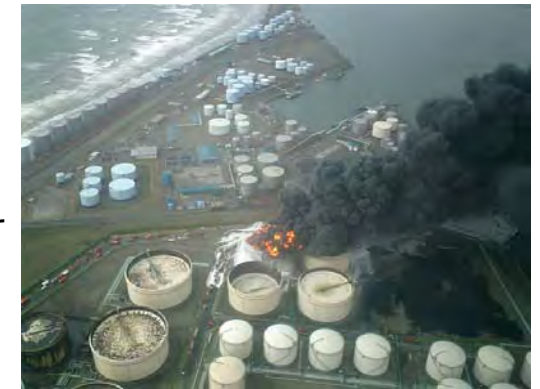
2003年十勝沖地震の苫小牧の石油タンク火災
