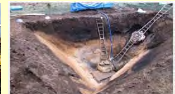
活断層帯のトレンチ調査
