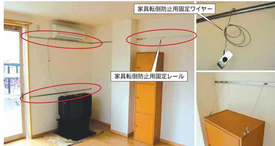
写真2 家具の固定用レールとワイヤーつき金具を備えた民間アパートの取組
