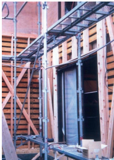
写真1 木造住宅の耐震補強のため外壁や基礎の増設を行う
