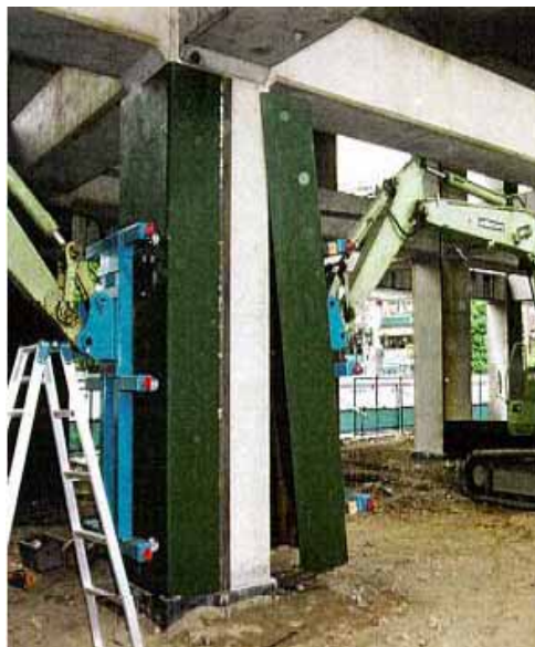
図 1.1.4 JR の実施した鋼板による柱補強の様子
