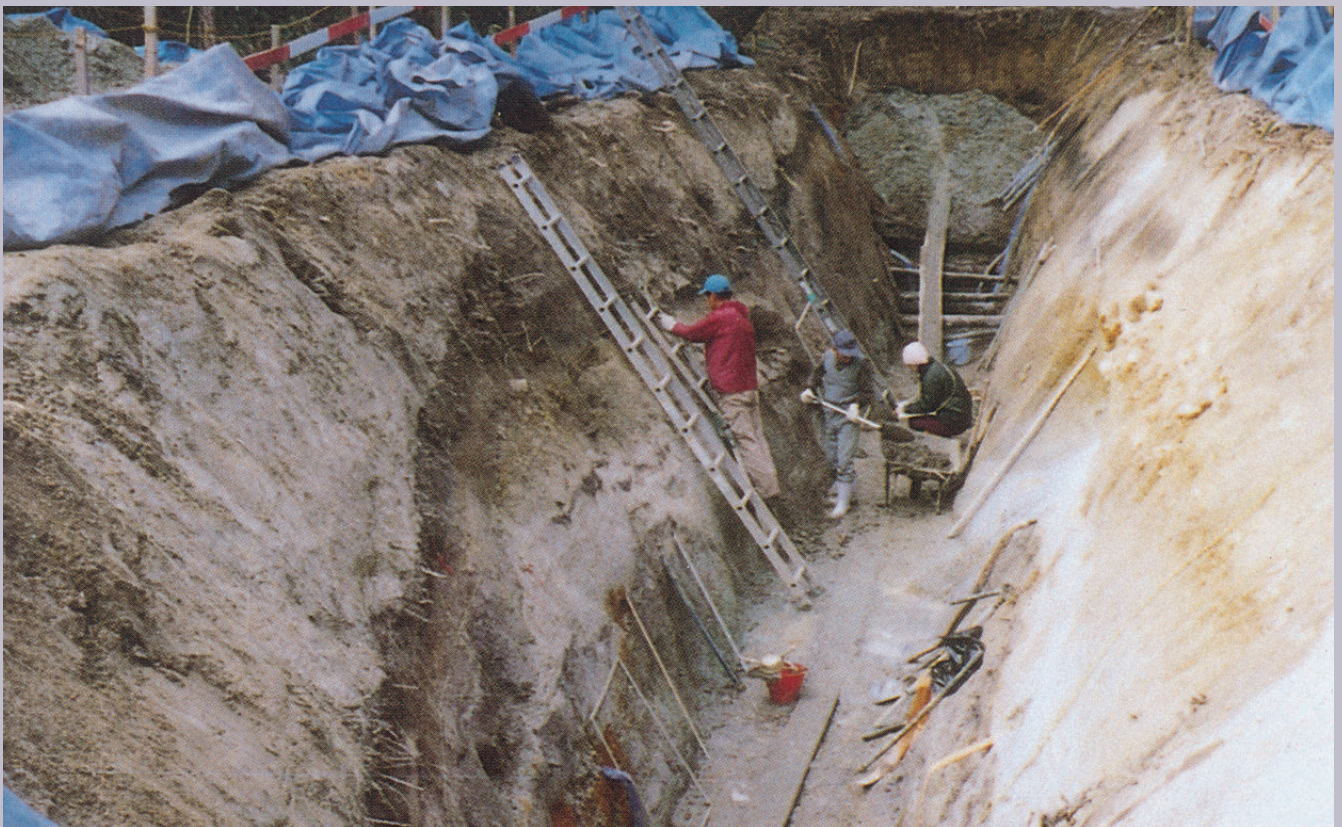
活断層のトレンチ調査の様子 (猿投山断層帯)
