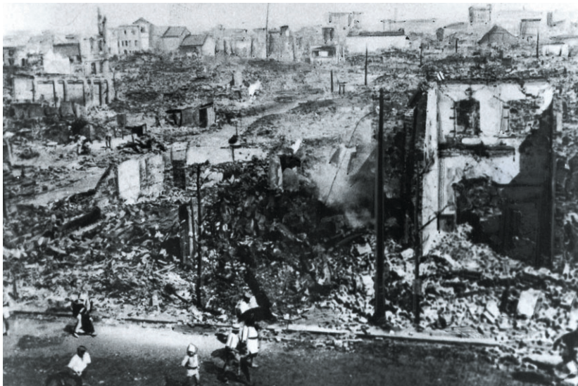
関東大震災。東京・京橋の惨状。
