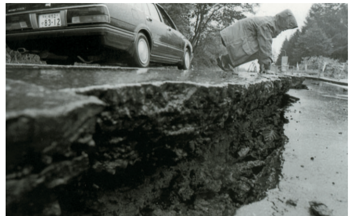
平成6年(1994年)北海道東方沖地震の被害。(毎日新聞社提供) 道路に亀裂が入り15cmもの段差ができた。
