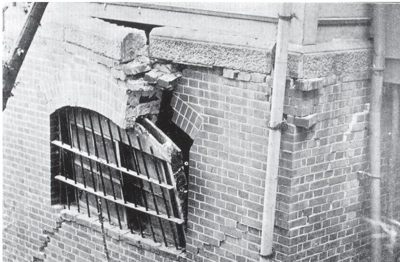
図 8 - 9 1905 年の芸予地震による広島監獄の大破 (曾禰, 1906)
