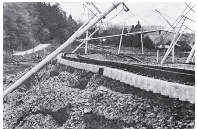
図4-18 「1968年十勝沖地震」による鉄道被害状況(東北本線石文~千曳間) [青森県(1969)による]
