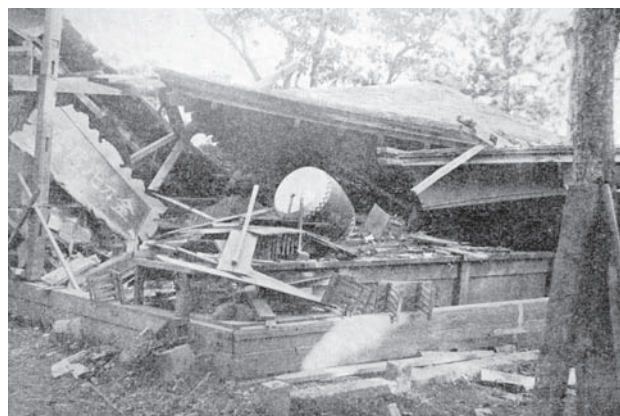
図4-5 陸羽地震による神社の崩壊(高梨村(旧名、現在の大仙市)) [秋田震災救済会(1897)による]
