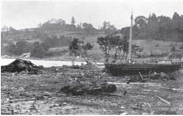
図4-8 明治三陸地震による被害状況(宮城県志津川町細浦(旧名、現在の南三陸町))
