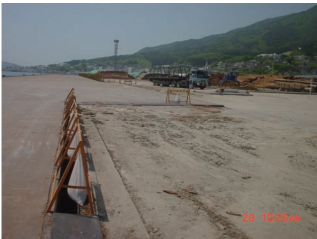
図4-36 2003年の宮城県沖の地震による液状化の被害写真(岩手県大船渡市) [国土地理院ホームページによる]
