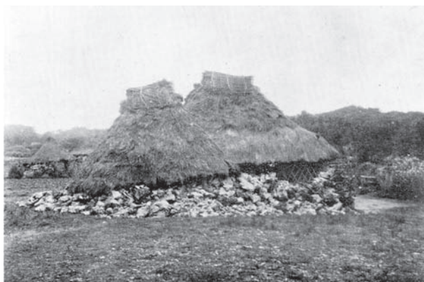
図9-11 1911年の奄美大島近海の地震による喜界村中間 なかま (旧名、現在の喜界町)における民家の倒壊 [今村明恒氏撮影]
