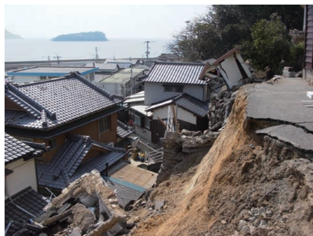
図9-19 2005年福岡県西方沖の地震によるがけ崩れで損壊した道路(福岡市玄界島) [気象庁(2005)より]
