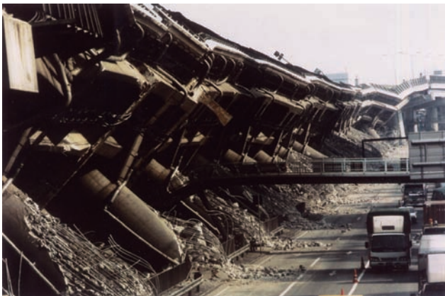
図7-20 「平成7年(1995年)兵庫県南部地震」により倒壊した高速道路(阪神高速神戸線) [毎日新聞社提供]
