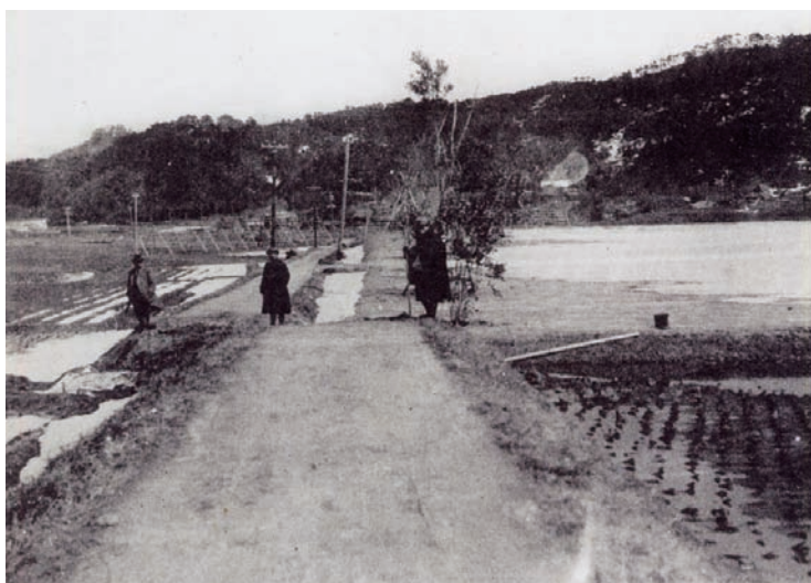
図7-7 北丹後地震による道路の食い違い
