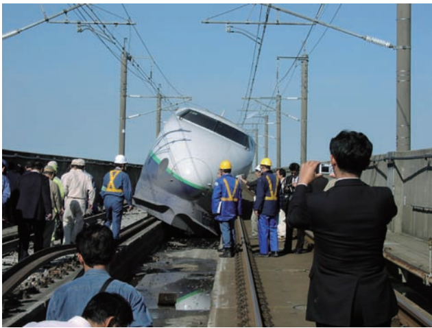
図6-37 「平成16年(2004年)新潟県中越地震」で脱線した上越新幹線 [気象庁撮影] 写真左下で、レールが曲がっているのが見られる。
