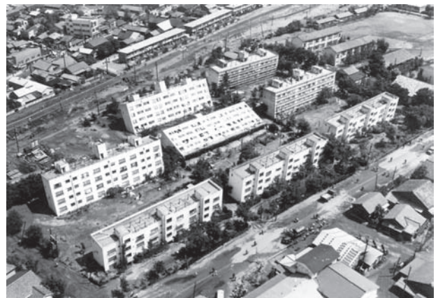
図6-21 「新潟地震」の液状化現象によるビルの倒壊 [新潟日報提供]
