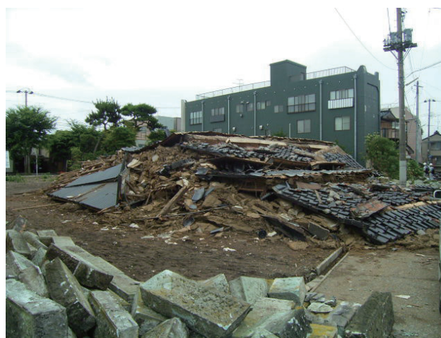
図6-45 「平成19年(2007年)新潟県中越沖地震」で全壊した木造家屋(新潟県柏崎市) [気象庁(2007)による]
