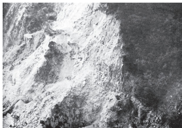
図6-33 「1978年伊豆大島近海の地震」における斜面の崩壊 [村井ほか(1978)による] 崖崩れによって通行不能になった稲取のトモ口岬付近の海岸道路。
