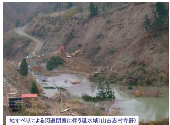
図6-36 「平成16年(2004年)新潟県中越地震」で生じた河道閉塞による湛水域 [鈴木ほか(2005)による]
