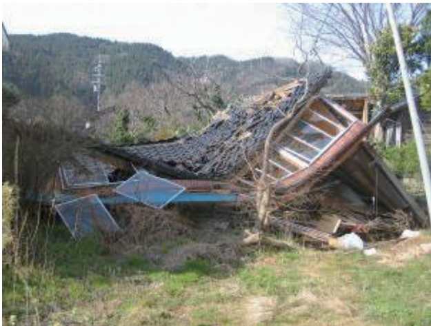
図6-41 「平成19年(2007年)能登半島地震」で全壊した家屋(石川県輪島市門前町) [気象庁(2007)による]
