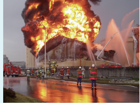
苫小牧での石油タンクの火災
