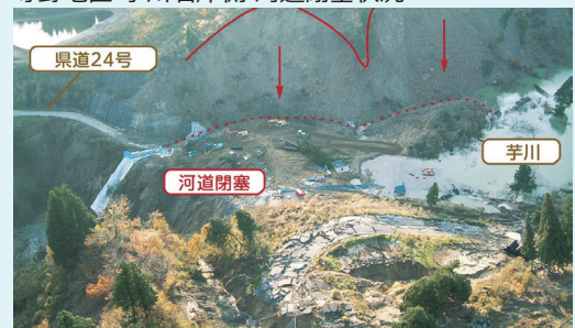
新潟県中越地震 長岡市(旧山古志村) 寺野地区 芋川右岸側 河道閉塞状況
