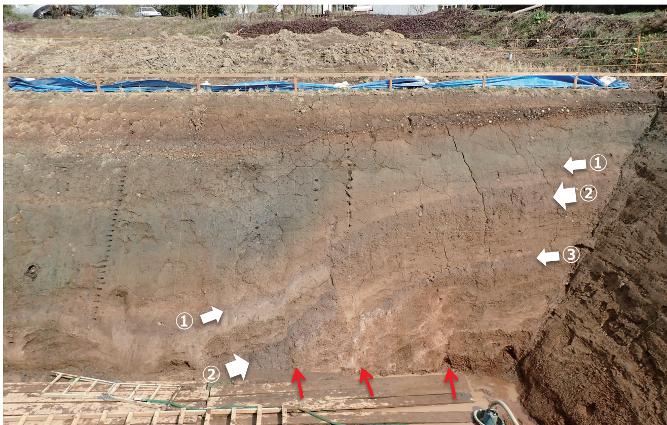
図2 山出トレンチの北壁面 赤矢印が断層、白矢印は炭素を多く含む焦げ茶色の地層（腐植質シルト層）を示します。
