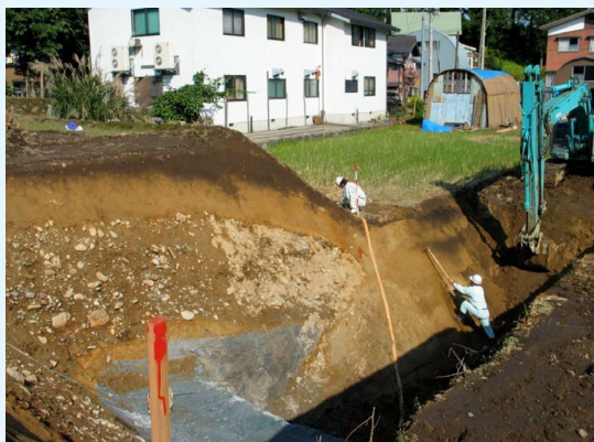
■ 活断層のトレンチ調査の様子
