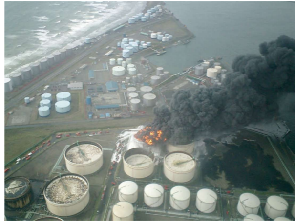
写真1 2003年十勝沖地震で発生した苫小牧の石油タンク火災 写真提供：総務省消防研究センター
