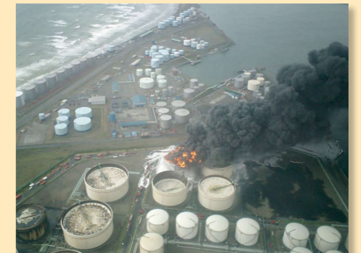
■長周期地震動:2003年十勝沖地震で発生した苫小牧石油タンク火災
