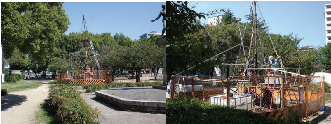
図 32 (左)新北島東公園における現地調査状況、(右)新北島西公園における現地調査状況
