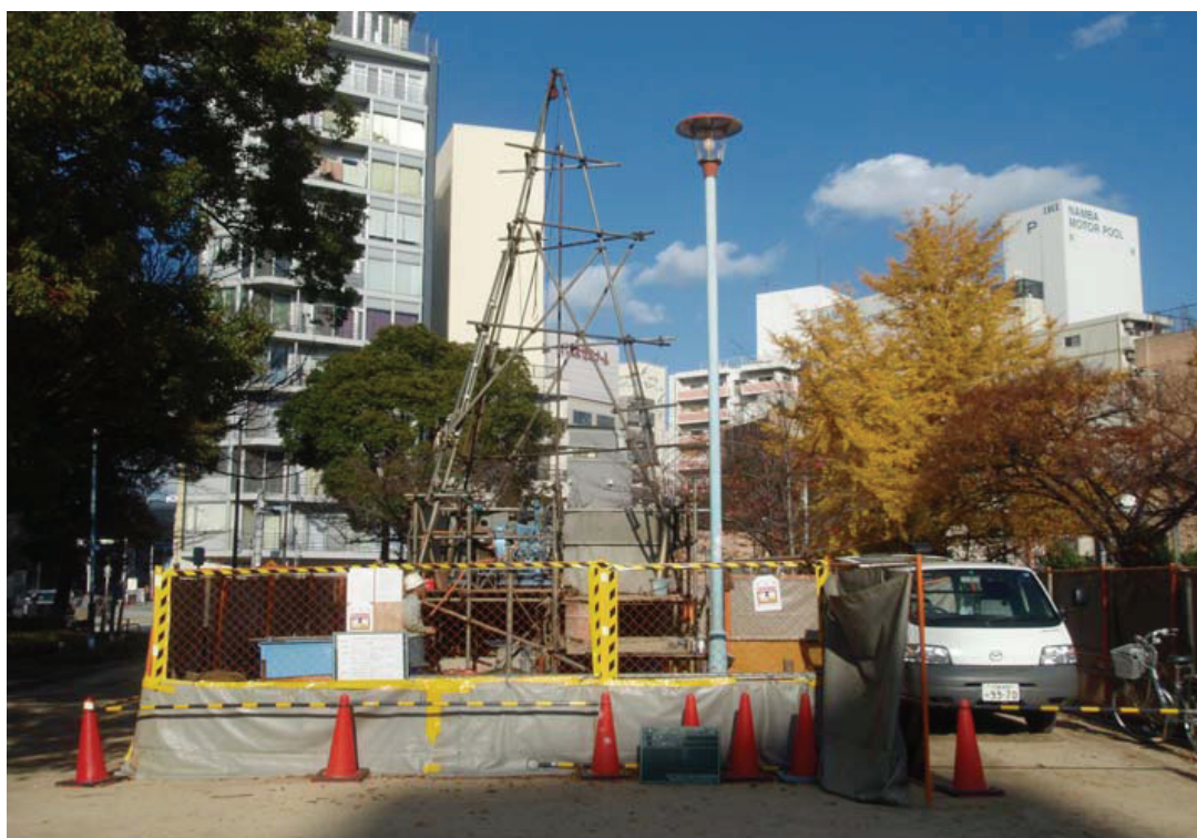
大阪市元町中公園（大阪市浪速区元町一丁目6番）におけるボーリング調査
