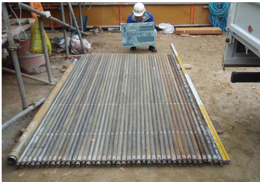
元町中公園におけるボーリング調査の検尺状況
