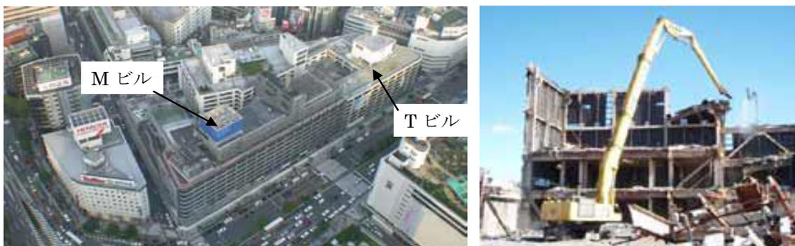
図67 解体前の対象建物と、ロングバックホーによる解体状況
