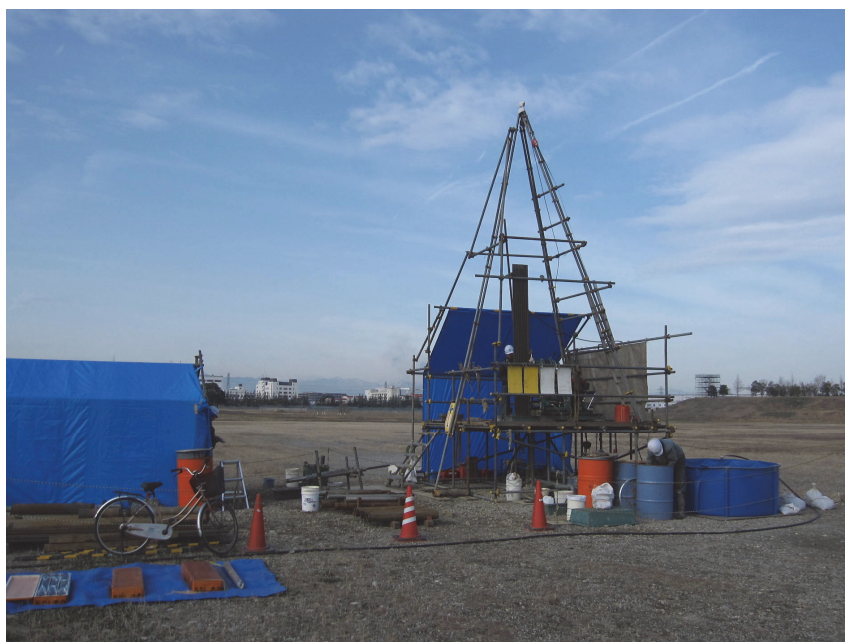
図 1 ボーリング掘削の状況
