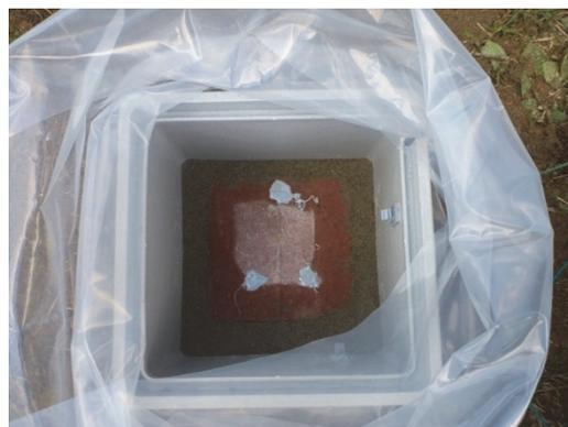
③ 雨水枘・敷石を挿入し真北に調整 ④敷石を速乾セメントで固定
