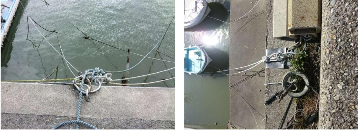
写真 3 - 2 - ( 2 ) - ① - 4 蜷川両岸の係留金具の例
