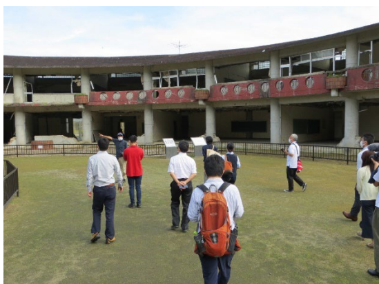
写真 2-8-②-11 東日本大震災被災地視察。大川小学校訪問
