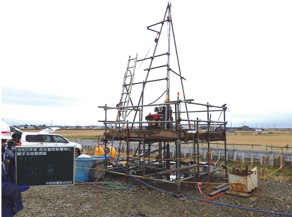
写真 16 金沢市千木町（地点 1）におけるボーリング掘削の様子
