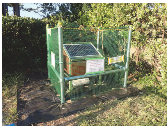
f : 周囲に防護ネットを施し完成
