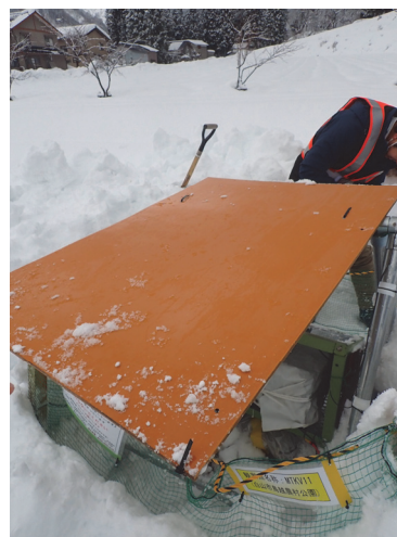
b：防護屋根の追加設置作業の様子
