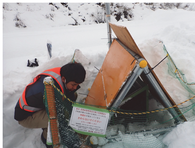
c：防護屋根設置完了後の様子
