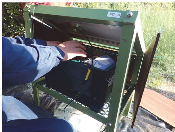
e : 機器箱を架台に固定
