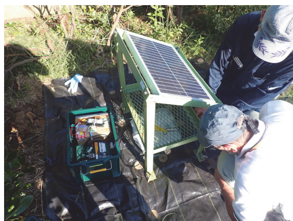
d : ソーラーパネル付架台を固定
