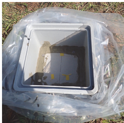
b : 石版・モルタルで土台を作る
