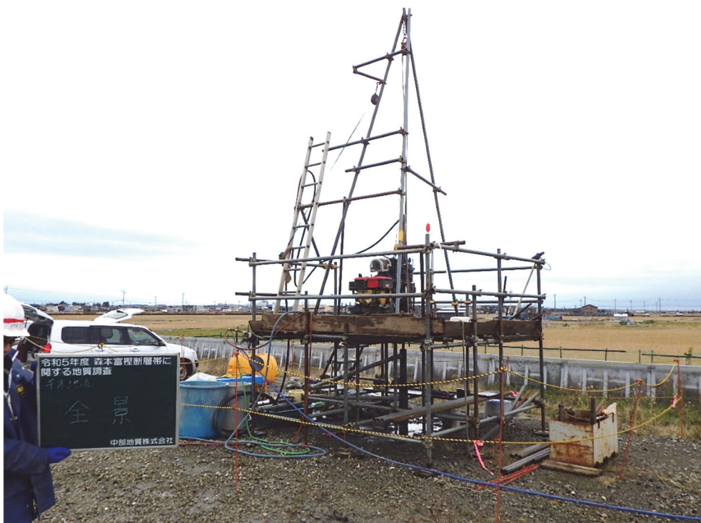
金沢市千木町におけるボーリング掘削
