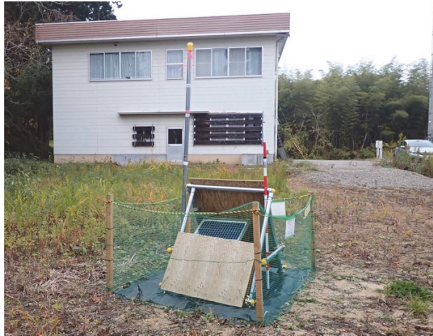
図3 積雪対策1回目完了時の様子（ソーラーパネル部分の屋根は外している：MTKV02）
