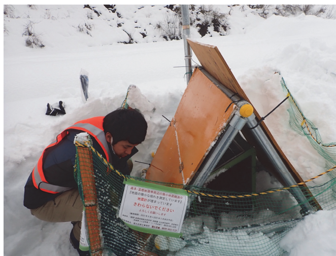
c：防護屋根設置完了後の様子
