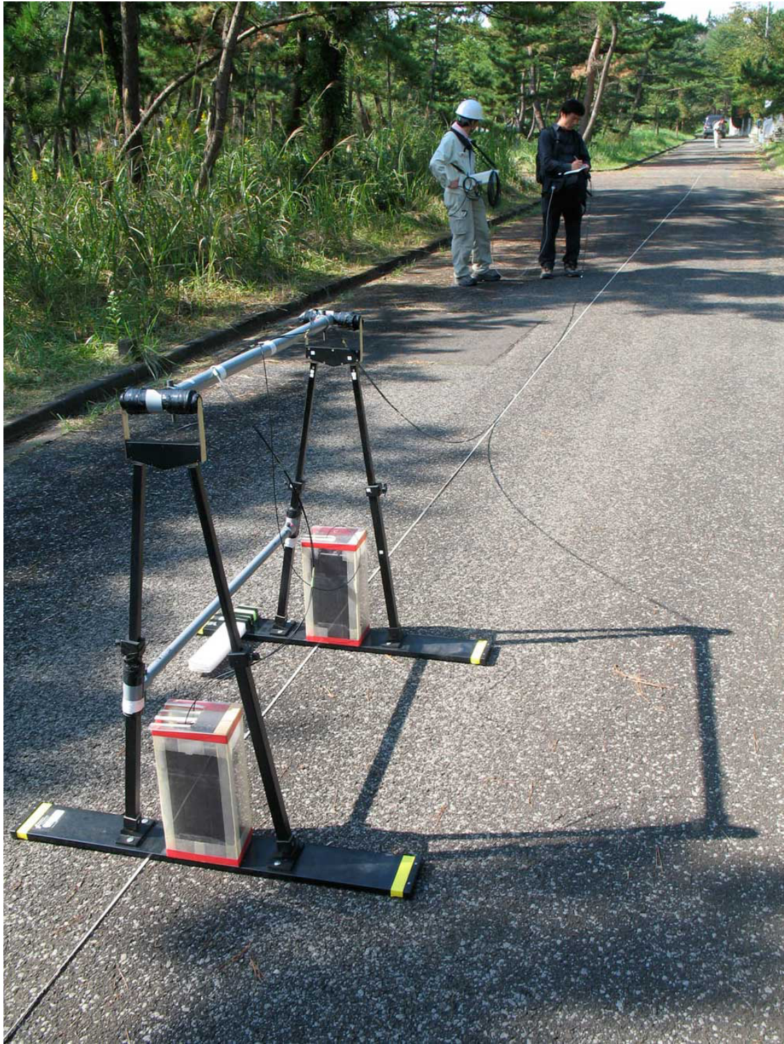
図 2 GPR 探査の様子
