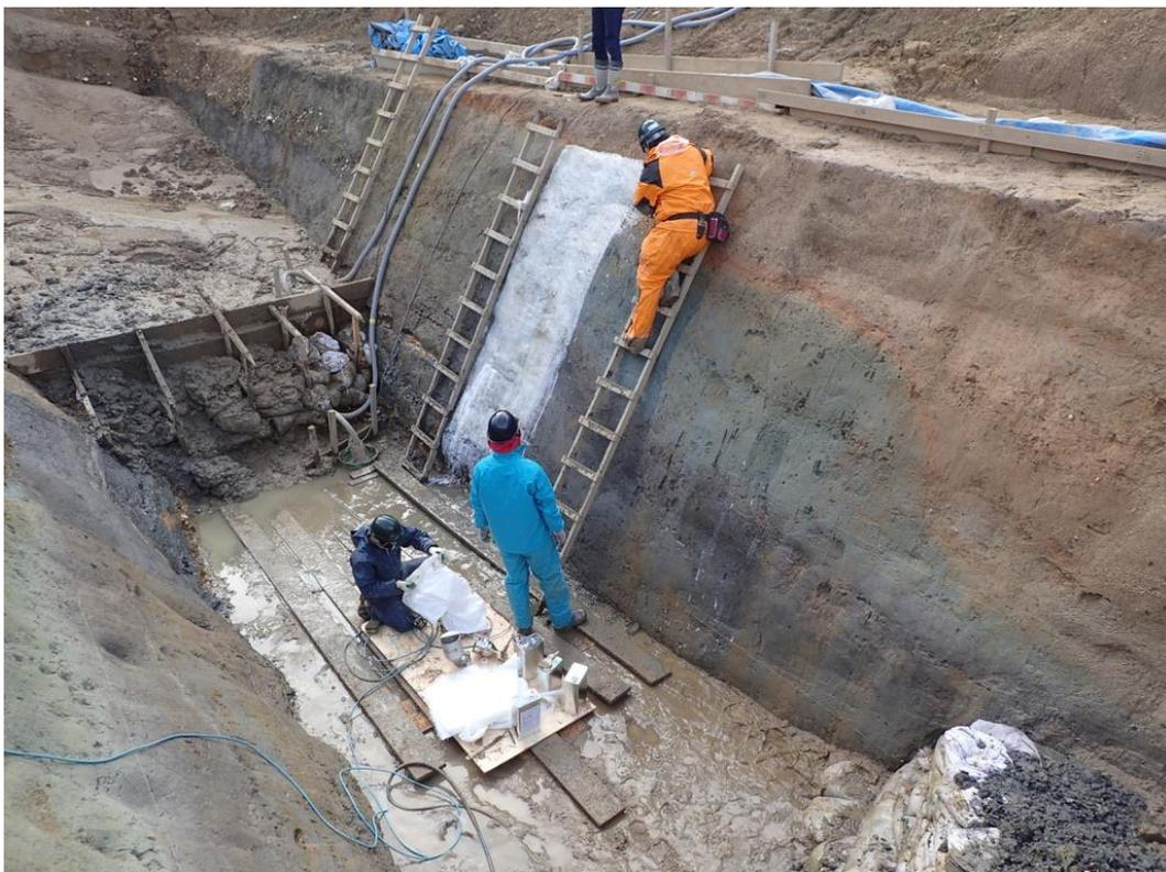
図3 日奈久断層帯八代市川田町西トレンチ剥取り作業状況 薬剤の塗布(南壁面)
