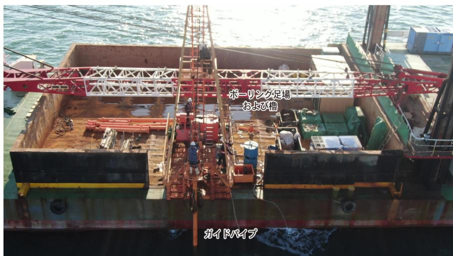
図 8 ボーリングマシンをガイドパイプの真上に移動させている状況
