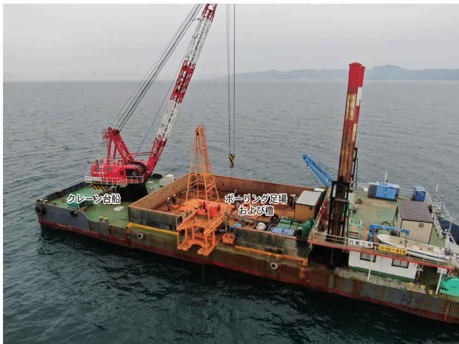
図 7 クレーン台船の船舷に設置したボーリング足場及び檣
