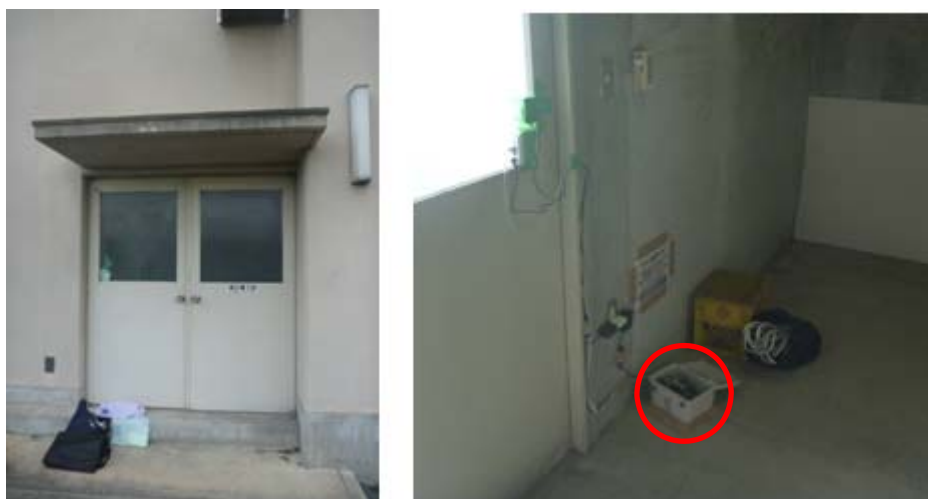
写真1 野間中学校観測点 (高圧電力室内)
