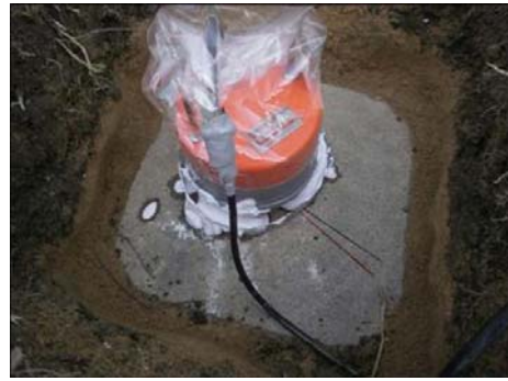
写真2 KG08点における地震計設置状況
