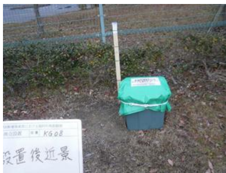
写真3 臨時機動観測点設置状況例 (KG08 ; 地震計埋設)
