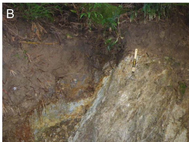
図6 筑紫野市西吉木の断層露頭のスケッチおよび写真 写真Aは2012年2月、写真Bは2012年7月撮影
