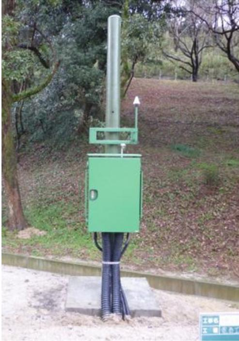
写真5 引込柱および野外収納箱外観
