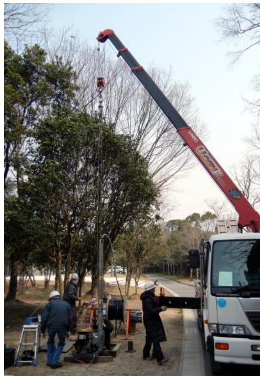
写真 4 観測装置設置の様子。クレーンに吊り下げられている銀色の筒状のものが観測装置である。
