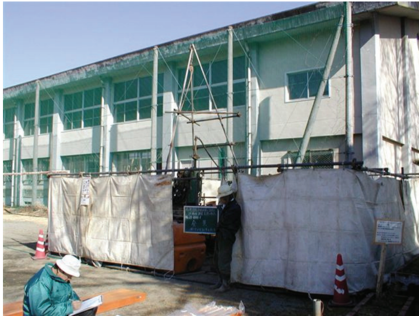
写真 1 北足柄中学校跡地における活断層ボーリング調査風景。
