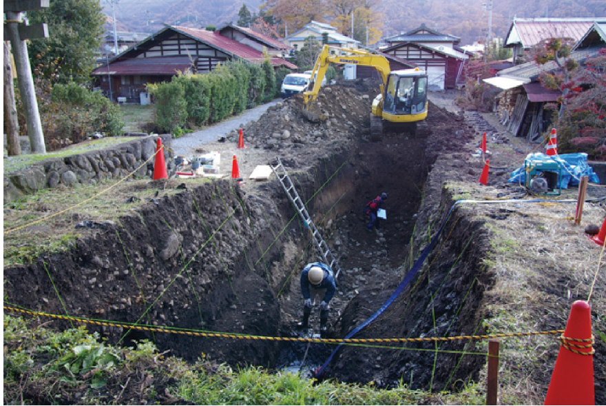
図 11 ちのトレンチ掘削状況。
