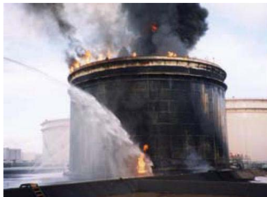
長周期地震動による石油タンクの被害 (左) 2003年十勝沖地震の苫小牧における火災 (右) 2011年東北地方太平洋沖地震時の被害 (いずれも消防研究センターのホームページより)
