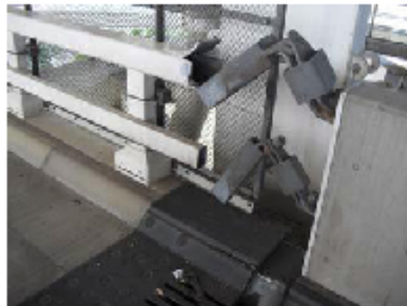
高層伸縮継ぎ手の損傷
