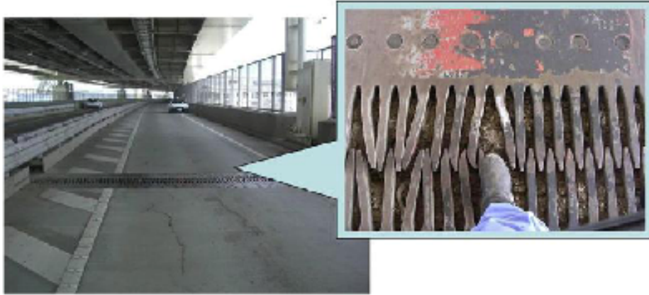
伸縮装置の損傷
