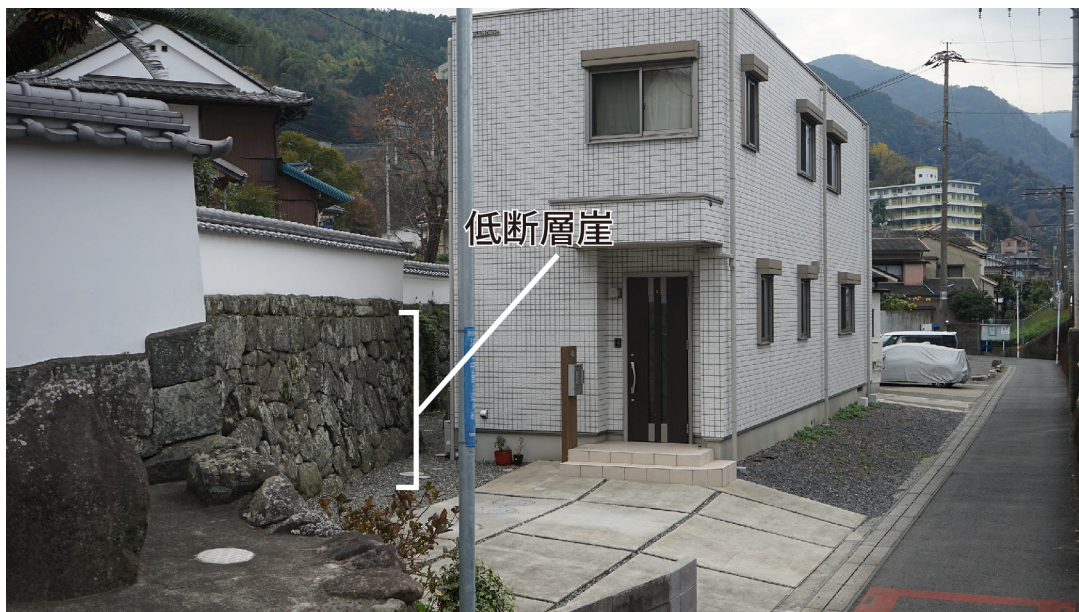
図5 浜脇地区の現地写真 写真は西に向かって撮影
