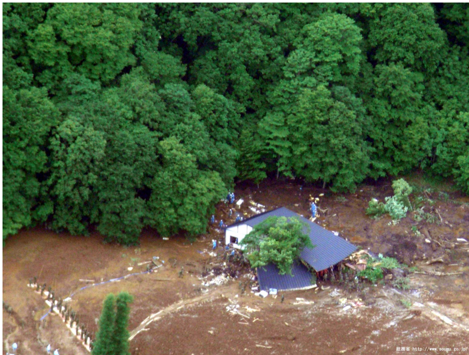
土石流に押し流された建物
