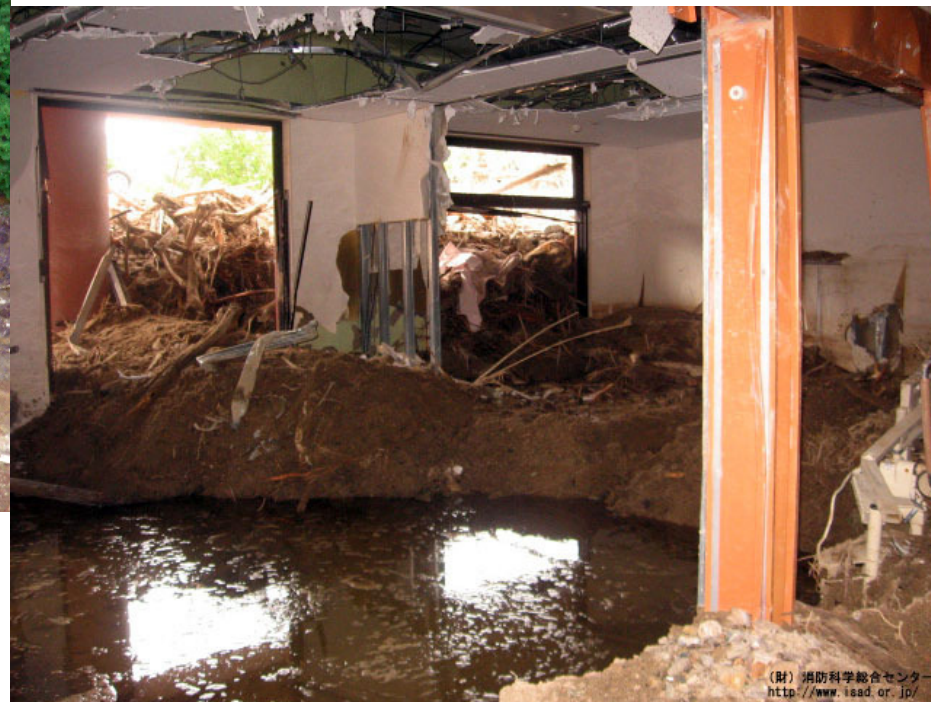
土石流が通った後の建物内部
